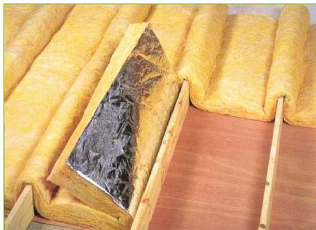
Isolation d'un plancher de grenier
